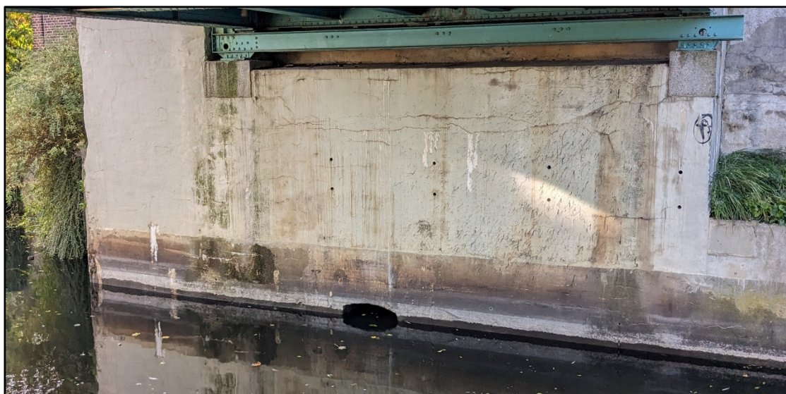
Bild 4.2.2-1 RW-Auslauf im WL Süd (Achse 10)
