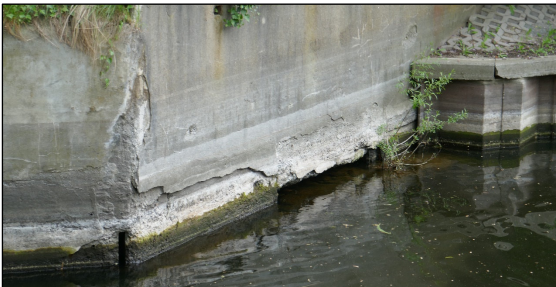
Bild 3.2-5 Straßenbrücke. WL Süd (Achse 10). Blick auf den unteren Bereich der Uferstützwand SW. Rechts im Bild die sich anschließende linksseitige Uferspundwand des Rathenower Stadtkanals. Unten eine rechteckige Öffnung.
