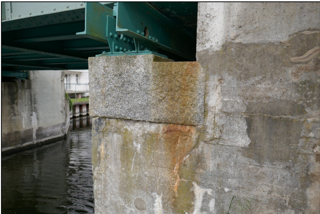
Bild 3.2-7 Straßenbrücke. WL Süd (Achse 10). Blick auf den Granitauflagerstein SW (10-1).
