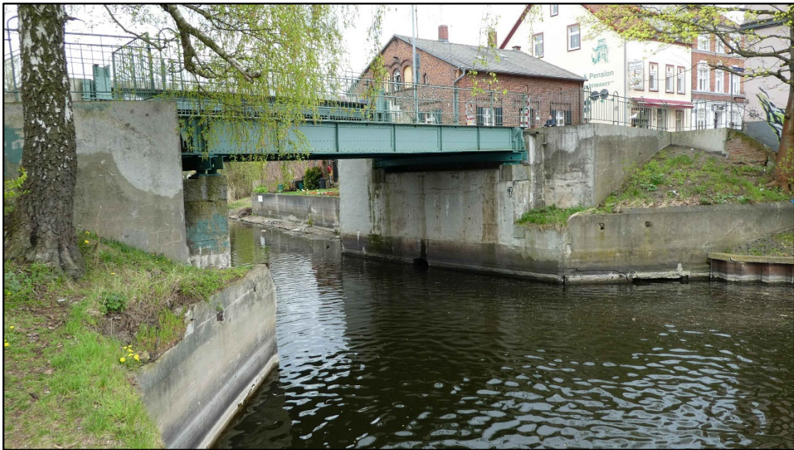
Bild 1.1-8 Blick vom nordwestlichen Ufer aus auf die Brücke; Bild „Seitenansicht 2016“ aus [2]
