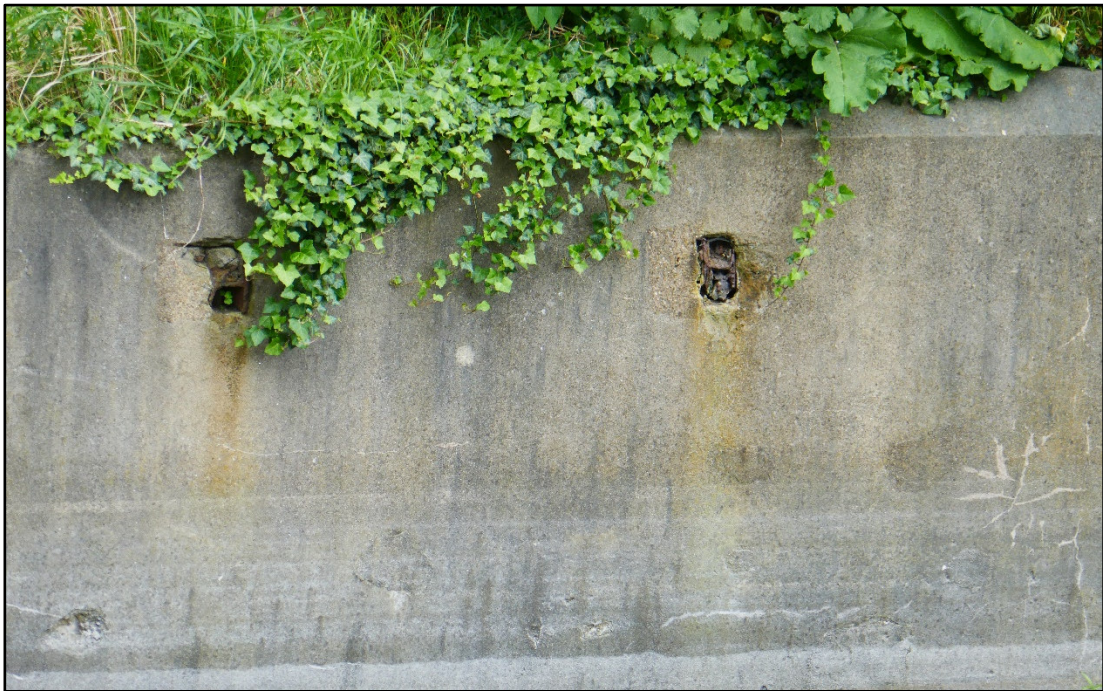
Bild 3.2-4 Straßenbrücke. WL Süd (Achse 10). Blick auf den oberen Bereich der Uferstützwand SW. An der Oberfläche sind die Ankerköpfe von zwei Ankerstellen zu sehen.
