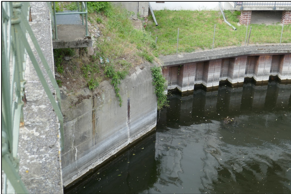
Bild 3.2-14 Fußgängerbrücke. WL Nord (Achse 20). Blick auf die Uferstützwand NO. Rechts im Bild die sich anschließende rechtsseitige Uferspundwand des Rathenower Stadtkanals.
