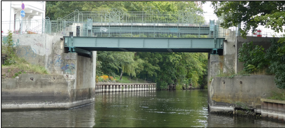
Bild 4.2.2-2 rechteckige Öffnung in Uferstützwand SW; Bild „Seitenansicht 2021“ aus [2]
