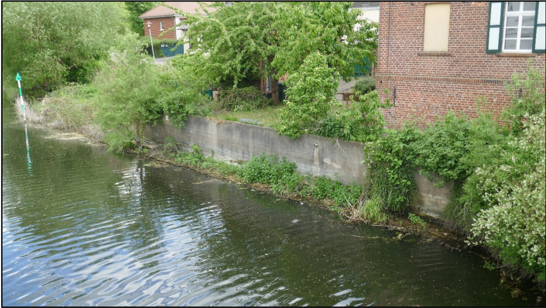
Bild 3.2-6 Fußgängerbrücke. WL Süd (Achse 10). Blick auf den östlichen Teil der Uferstützwand SO.
