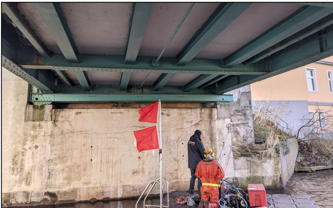
Bild 4.1-1 Blick auf den Ponton vor dem WL Süd (Achse 10); der Wahrschauer sichert gegen eventuellen Schiffsverkehr ab, der Signalmann hält den Kontakt zum Taucher, der unter Wasser im Einsatz ist
