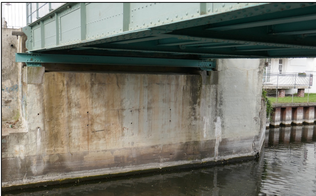
Bild 3.2-9 Doppelbrücke = Straßenbrücke und Fußgängerbrücke. Blick auf das WL Nord (Achse 20). Rechts im Bild die rechtsseitige Uferspundwand NO.
