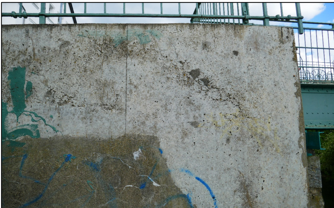
Bild 3.2-12 Straßenbrücke. WL Nord (Achse 20). Blick auf den Flügel NW.
