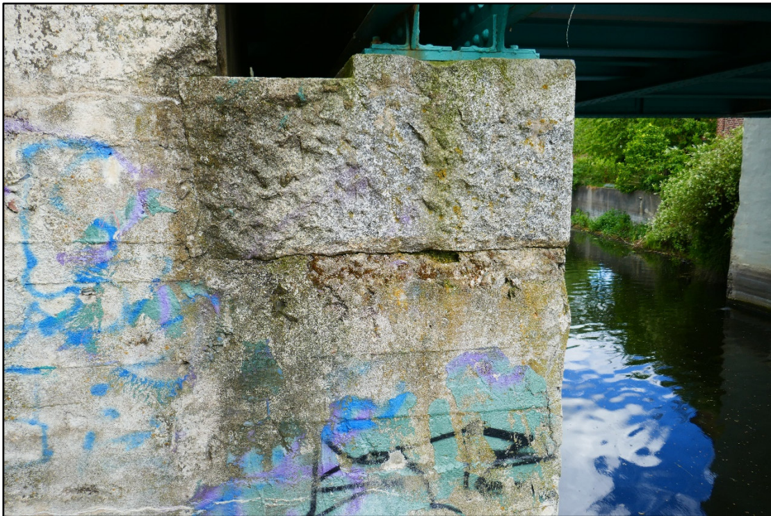
Bild 3.2-11 Straßenbrücke. WL Nord (Achse 20). Blick auf den Granitauflagerstein NW (20-1).
