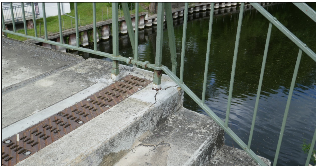
Bild 3.2-15 Fußgängerbrücke. Blick auf die Pfostenverankerung des rechten Geländers auf der obersten Stufe der südlichen Treppe.
