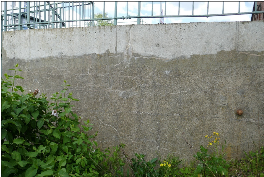
Bild 3.2-8 Straßenbrücke. WL Süd (Achse 10). Blick auf den Flügel SW.
