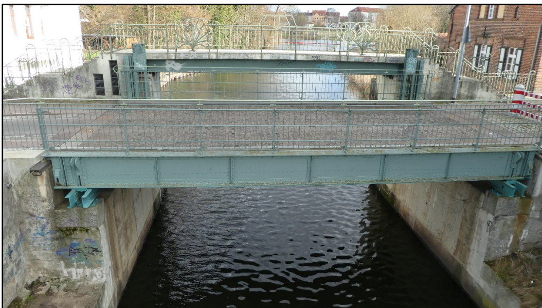
Bild 1.1-9 Blick von oben auf die Straßenbrücke, dahinter das höherliegende Teil-BW mit den beidseitigen Treppen; Bild „Seitenansicht 2022“ aus [2]
