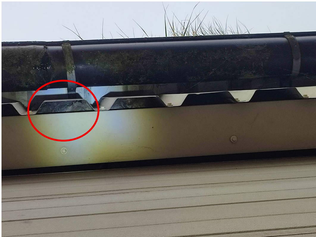
Abbildung 5: Dämmmaterial verdeckt Öffnungen (rot eingekreist)
