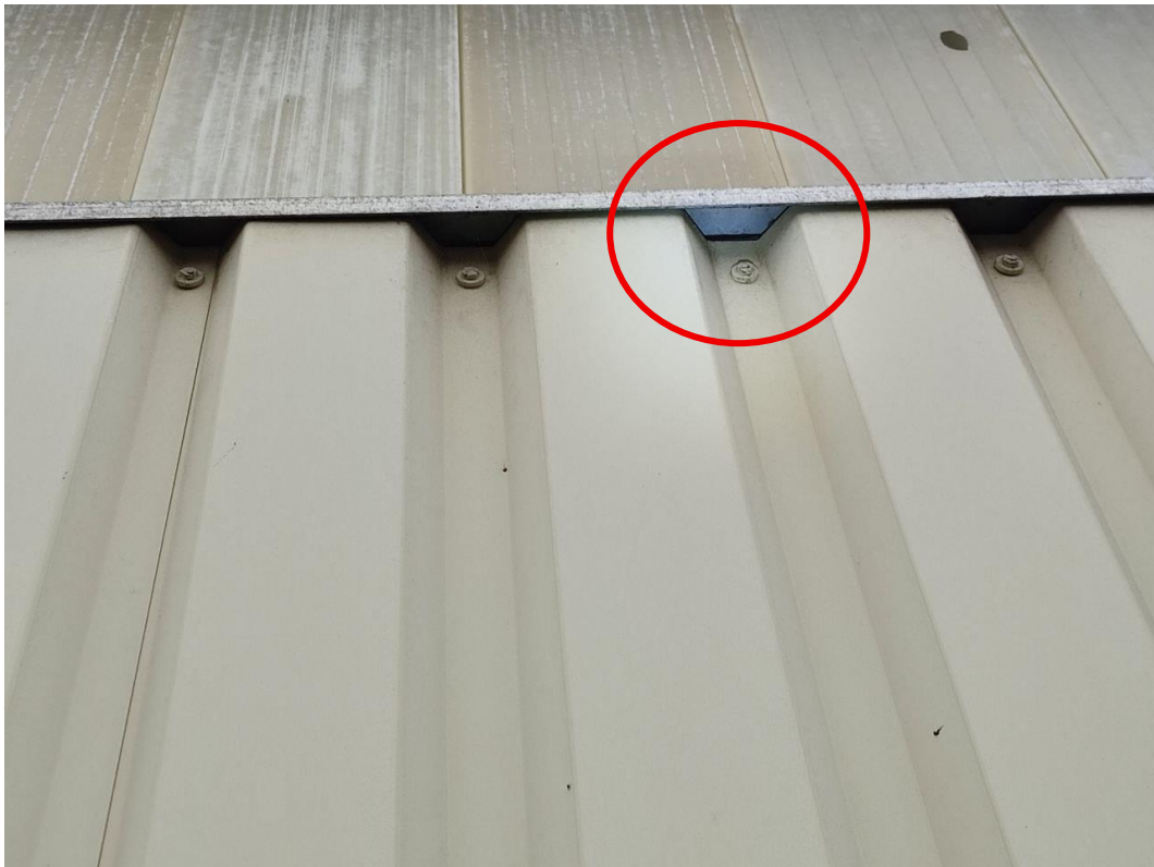
Abbildung 4: verschlossene Öffnungen (rot eingekreist)
