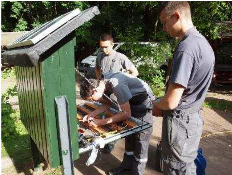
Bau einer Tierstimmenstation
