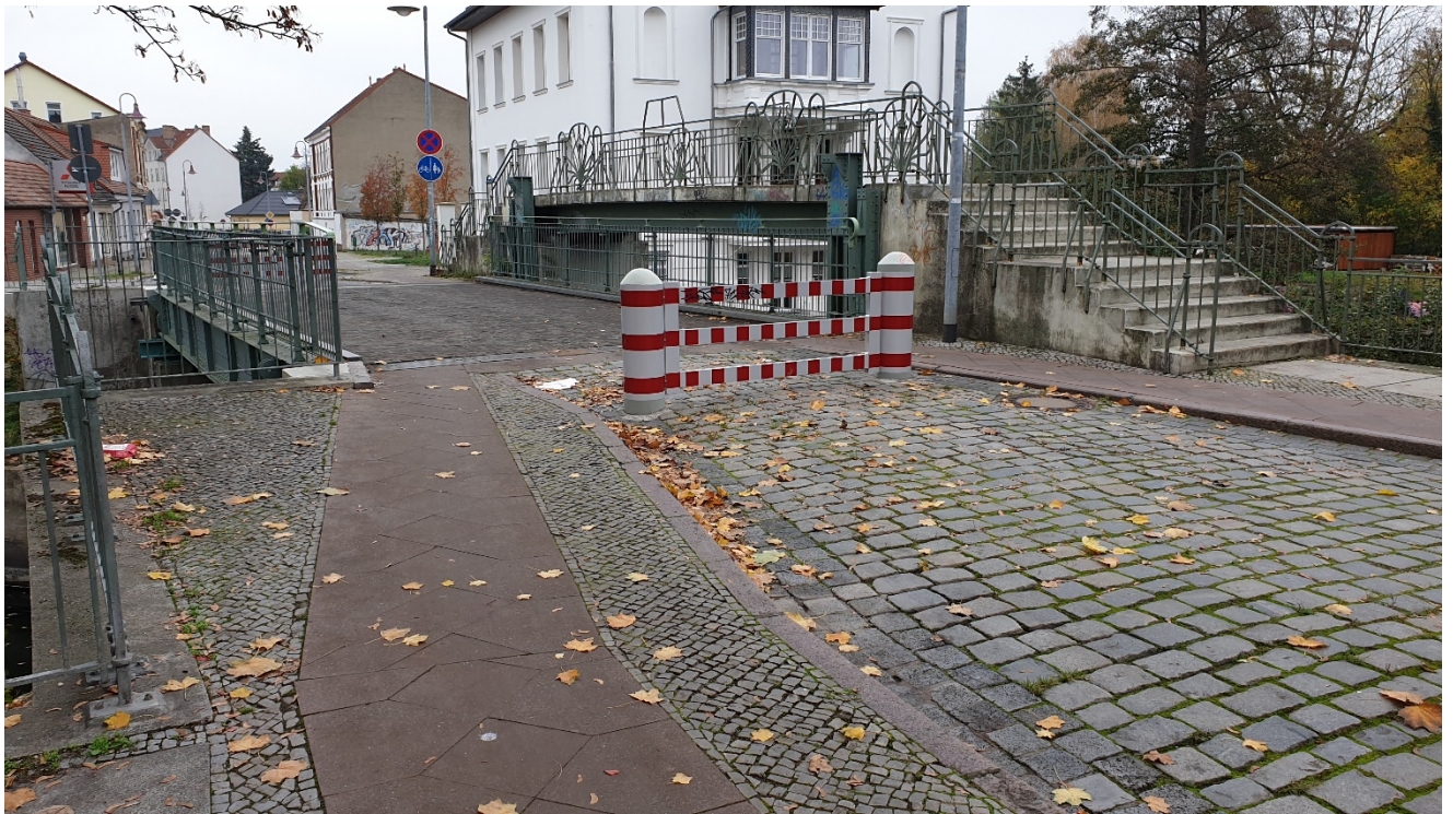
Bauwerkslage in Stationierungsrichtung
