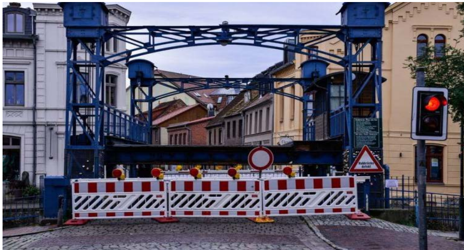
Vollsperrung der Plauer Hubbrücke
