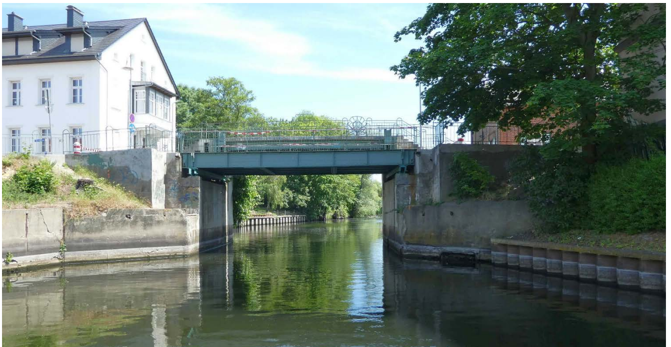
Seitenansicht der Straßenbrücke von links
